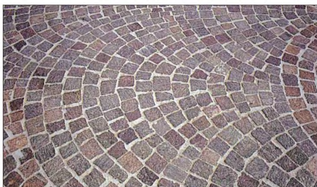
Esempio di pavimentazione in cubetti in porfido con disposizione a coda di pavone (o a ventaglio). Dimensione cubetti: 8 / 10 cm
