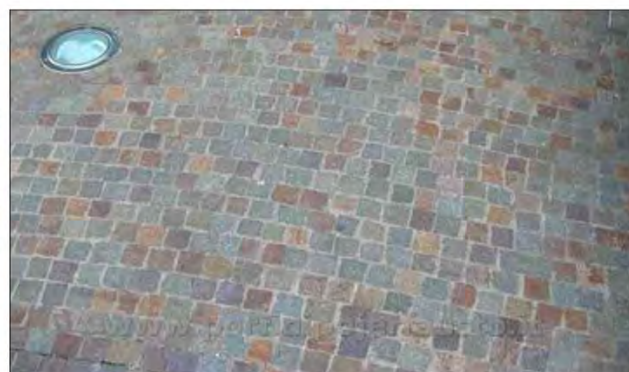
Esempio di pavimentazione in cubetti in porfido con disposizione a file parallele "a correre". Dimensione cubetti: 8 / 10 cm
