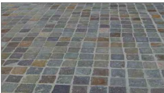
Esempio di pavimentazione in cubetti in porfido con disposizione a file parallele "a carrè". Dimensione cubetti: 8 / 10 cm
