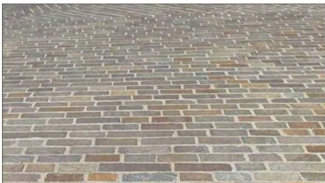
Esempio di pavimentazione in lastre di porfido rettangolari con disposizione a file parallele "a correre"
