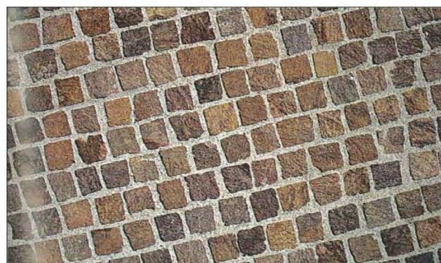
Esempio di pavimentazione in cubetti in porfido con disposizione a file parallele "a correre". Dimensione cubetti: 8 / 10 cm
