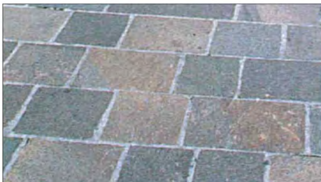
Esempio di pavimentazione in lastre di porfido rettangolari e quadrate con disposizione a file parallele "a correre"
